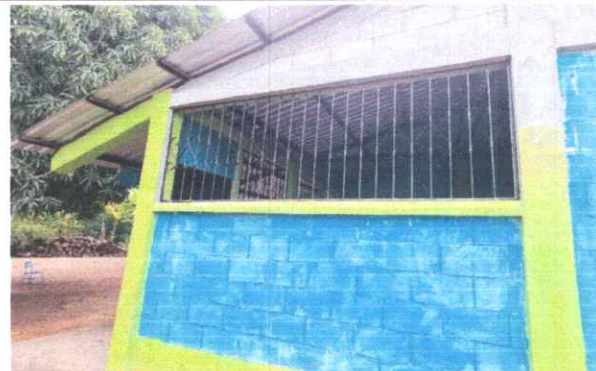
Foto 2: Vista exterior de módulo 1 de aulas, con intervención de remozamiento con mantenimiento a estructura.
