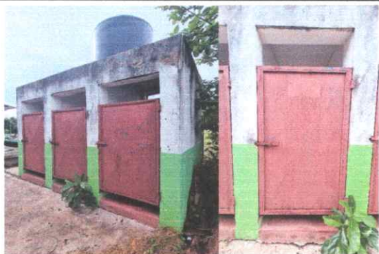
Foto 7: Vista de exterior de servicios sanitarios con intervención en remozamiento con aplicación de pintura y mantenimiento a puertas.
