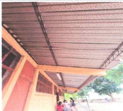
Foto 1: Vista exterior de módulo 1 de aulas, con intervención de remozamiento con mantenimiento a estructura.
