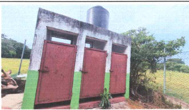
Foto 6: Vista exterior servicios sanitarios con intervención en el remozamiento en suministro e instalación de otro depósito de agua y accesorios.
