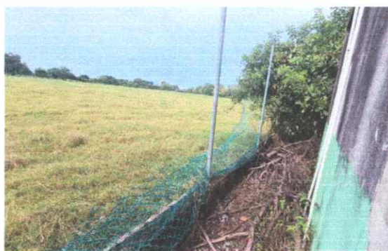
Foto 9: Vista muro perimetral, con intervención en remozamiento con muro de block
