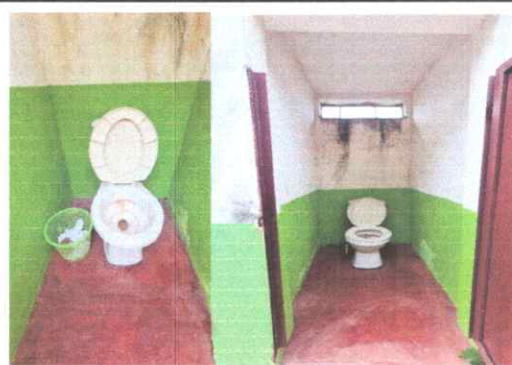
Foto 8: Vista interior servicios sanitarios con intervención en remozamiento con suministro e instalación de piso cerámico antideslizante, azulejo y sanitarios.
