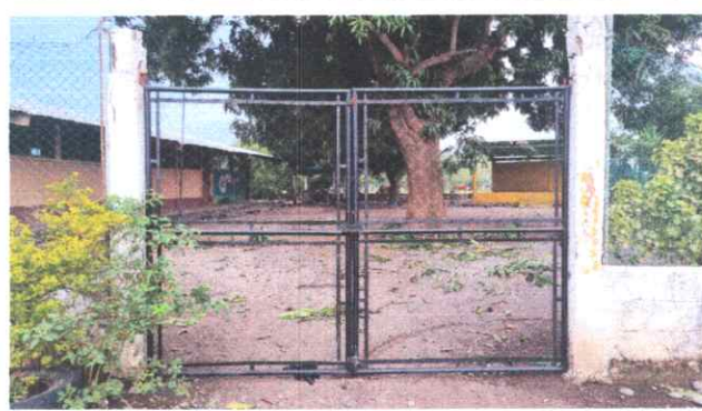
Foto 4: Vista exterior del establecimiento, con intervención en remozamiento de mantenimiento a portón de ingreso.
