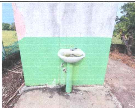
Foto 10: Vista exterior de servicios sanitarios, con intervención remozamiento con lavamanos con plancha de concreto y 3 chorros.
